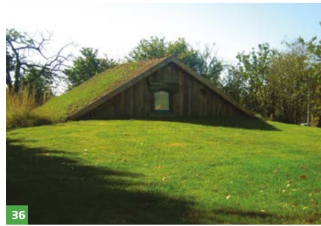
Maison semi-enterrée ou « écolodge » - XXI e siècle - Saint-M'Hervé (Bretagne, France)
