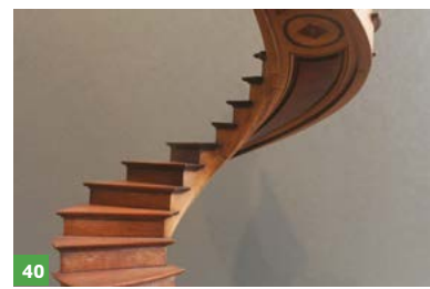
Escalier à vis à droite, à l'anglaise, du menuisier Poulin - 1830 - France
