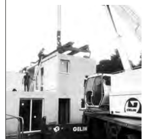
> LES MAISONS DES GENDARMES ONT ÉTÉ LIVRÉS EN 4 OU 5 MODULES POUR EN SUITE ÊTRE ASSEMBLÉES SUR PLACE.
