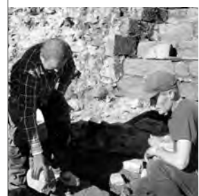
> LE CHANTIER BÉNÉVOLE APPREND LES TECHNIQUES DE BÂTI ANCIEN.
