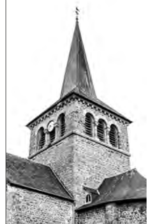
> LE CLOCHER DE L'ÉGLISE DE HÉDÉ, CLASSÉE MONUMENT HISTORIQUE, SERA RÉNOVÉ PLUS DE 100 ANS APRÈS SA DERNIÈRE RECONSTRUCTION
