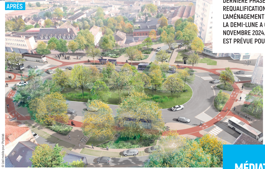
L'aménagement sécurise les circulations piétonnes et cyclistes.
