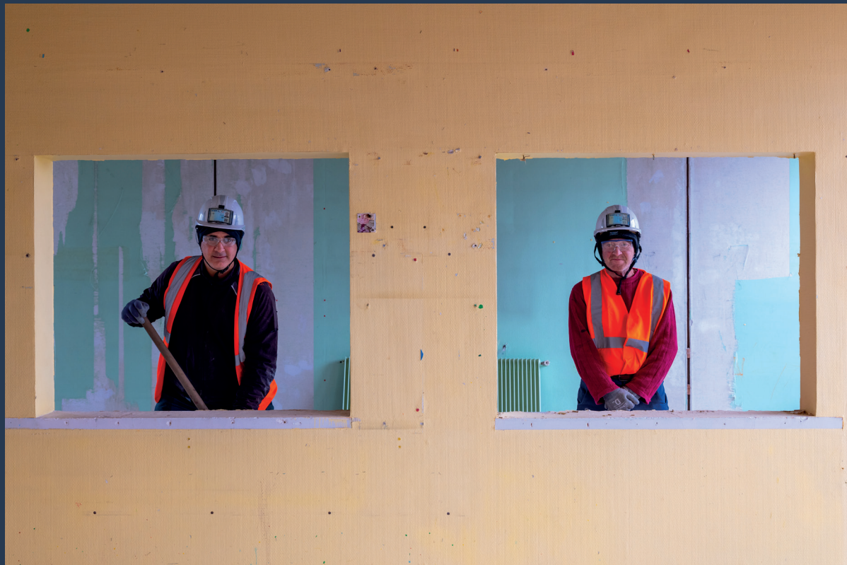
Khaled (à gauche) et Pascal travaillent sur le chantier de déconstruction depuis le début.
