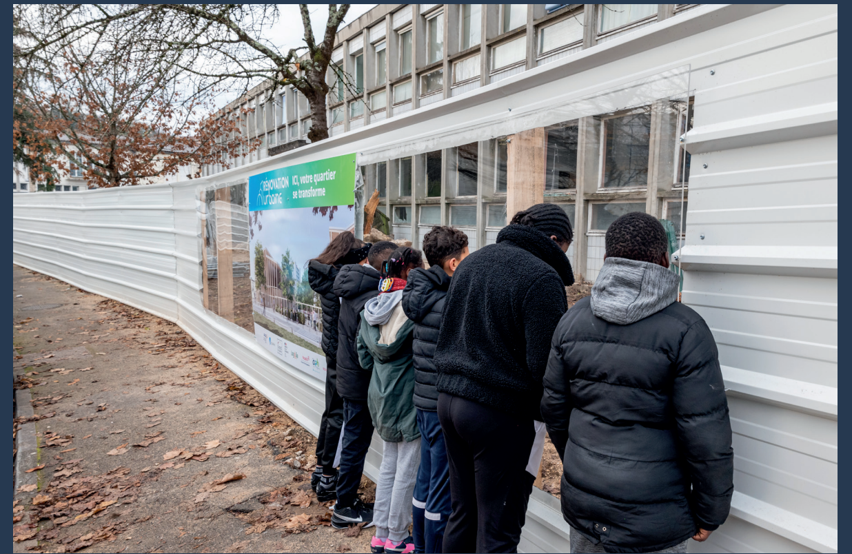
Des plexiglas ont été installés afin que les habitants du quartier puissent suivre l'avancée du chantier des écoles.
