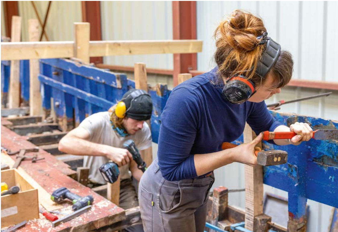
Les charpentiers de l'Atelier Ribines s'attaquent aux jambettes du Bass Loc'h, le bateau du club de plongée d'Audierne.
