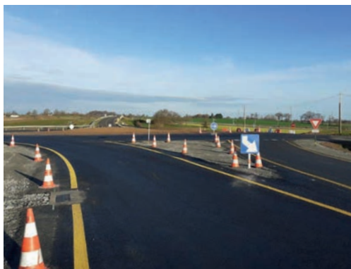
Le chantier devrait se terminer fin 2022.
